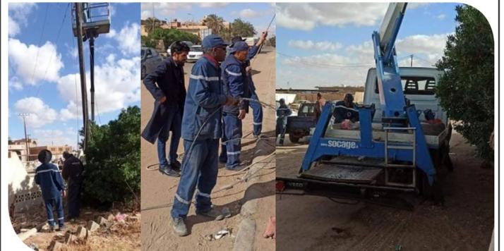
نفذت فرق الصيانة بدائرة توزيع شرق سبها، التابعة للشركة العامة للكهرباء، أعمال صيانة لمكونات شبكة التوزيع. وأشارت العامة للكهرباء أن الأعمال شملت تركيب أعمدة خشبية بدل المكسورة وسحب الأسلاك، وإعادة التغذية الكهربائية لبعض الأحياء بعد استكمال أعمال الصيانة الطارئة. يشار إلى أن هذه الأعمال تأتي ضمن جهد الشركة المتواصل لاستقرار وتحسين أداء الشبكة الكهربائية.
