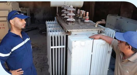
قام قسم الصيانة بدائرة النهر في مدينة أجدايا بتركيب محول كهرباء جديد بالمحطة الواقعة في شارع انتلات. وأوضح المكتب الإعلامي للبلدية أن تركيب المحول جاء نظراً لتلف المحول القديم بالمحطة، والذي تسبب في انقطاع التيار الكهربائي عن هذه المنطقة، موجهاً الشكر لكافة أعضاء فريق الصيانة الذي يقوم بهذه الأعمال
